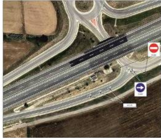
En intersecció canalitzada
