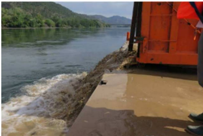
Prova pilot d'injecció de sediments a Benifallet
