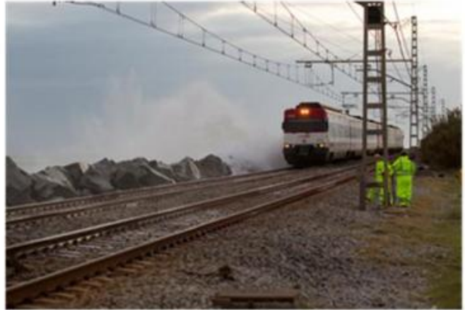
Afectació de la via del tren en el tram Premià - Vilassar
