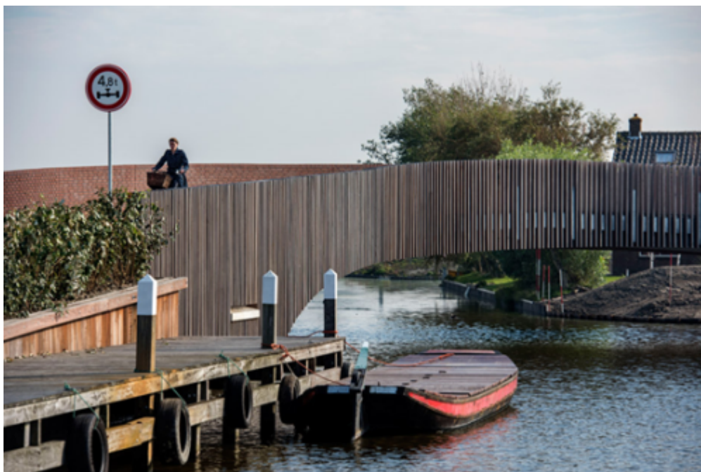
El pont, de riba a riba del Vlotwatering, és per a vianants i ciclistes (© NEXT Architects)
