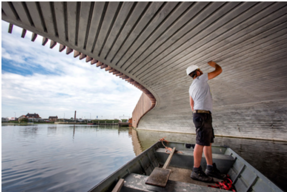
Uns darrers retocs a la part inferior del pont, on s'ubiquen les entrades per als ratpenats (© NEXT Architects)
