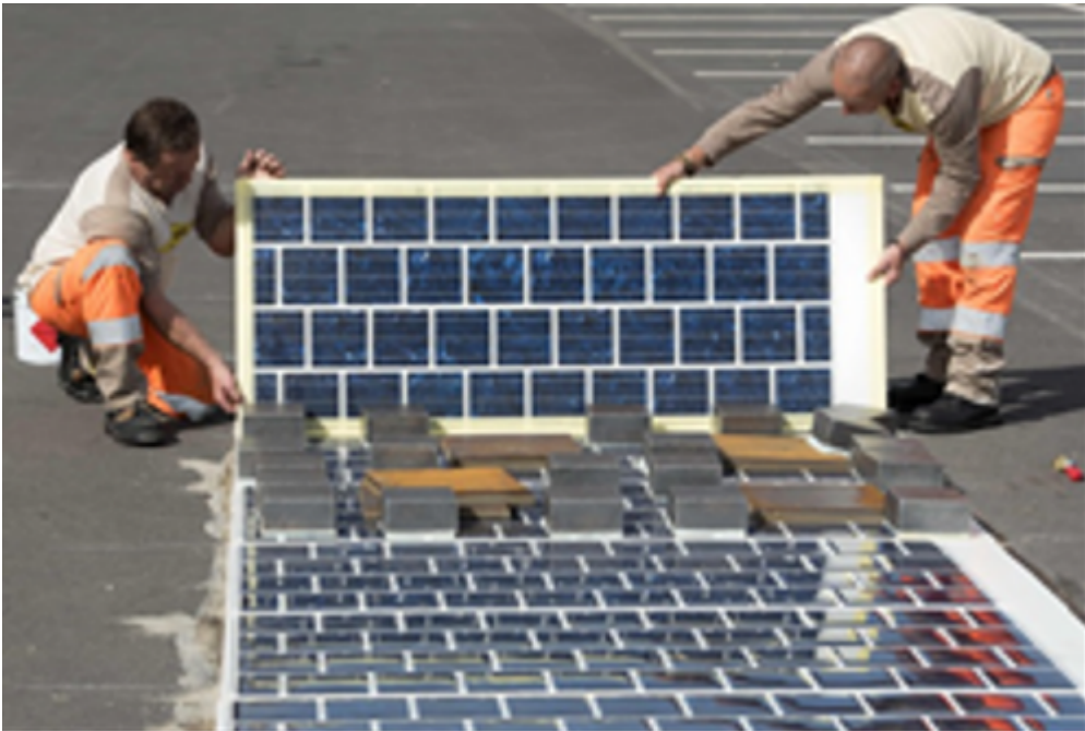
La instal·lació de Wattway no requereix obres majors (© Colas)
