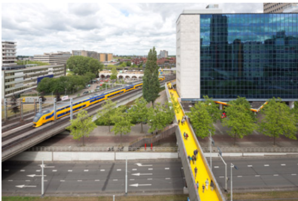
El color groc confereix al conjunt del Luchtsingel una identitat visual clara. Aquest color s'ha aplicat a les diferents parts de la passarel·la i a zones adjacents, per estendre la ruta més enllà de l'estructura
