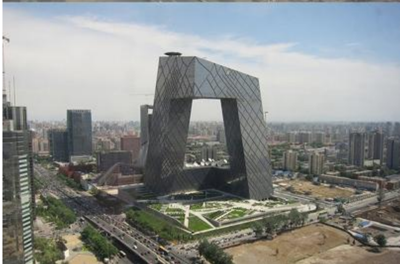
L'edifici de la televisió pública xinesa (CCTV), a Pequín.
