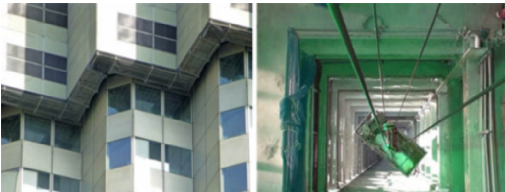
A l'esquerra, detall de la bastida adossada a l'exterior de l'edifici; a la dreta, descens dels materials cap a la planta baixa, pel forat de la llosa de tots els pisos.
