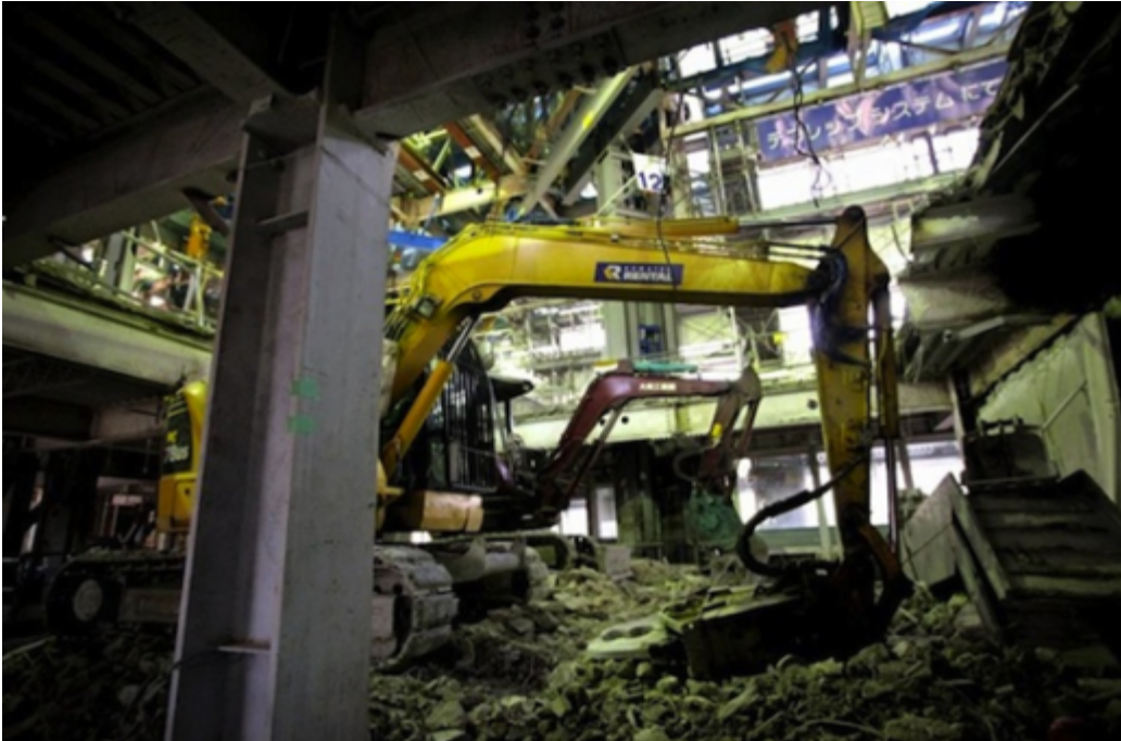
Els treballs de l'interior.
