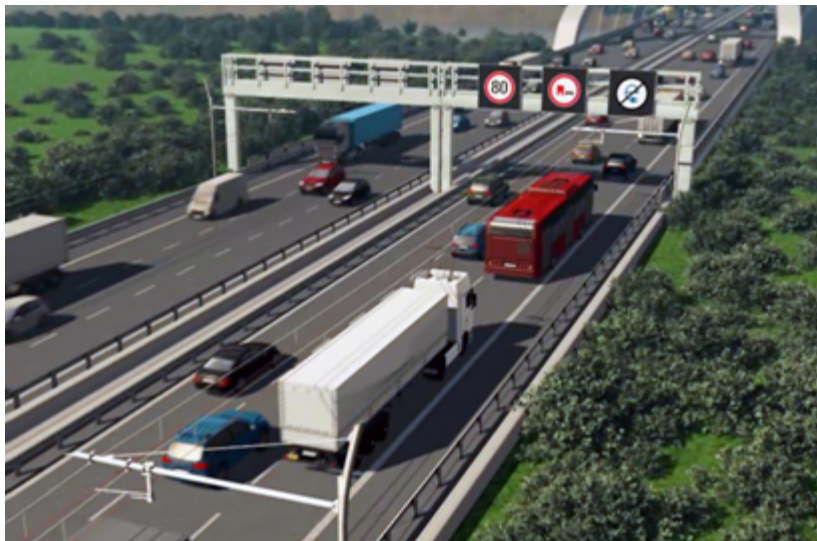
Simulació de funcionament del sistema eHighway, amb indicació de final de catenària
