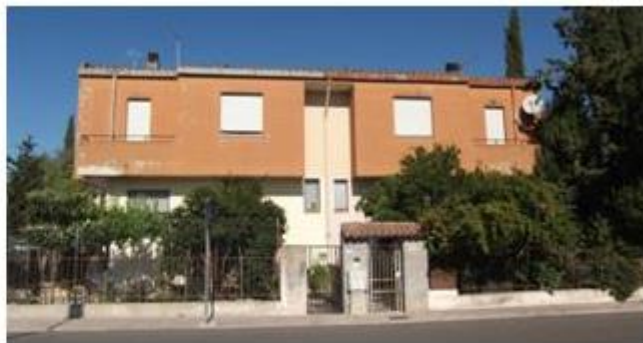
Edifici pilot a Cagliari
