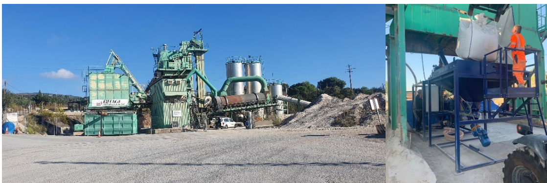
Figura 4. Detalls de la planta emprada. (Esquerra: vista general planta Eiffage Valls. Dreta: dosificador d'additius sòlids per a dosificació d'NFVU)
