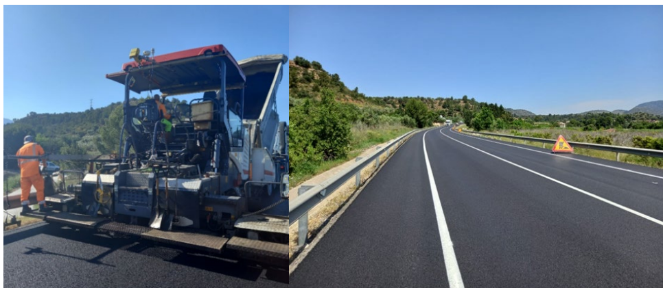
Figura 2. Detalls de l'estesa (esquerra) i tram finalitzat (dreta)
