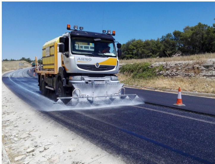
Fotografia 4: aplicació de la beurada de calç per protegir el reg d'adherència.
