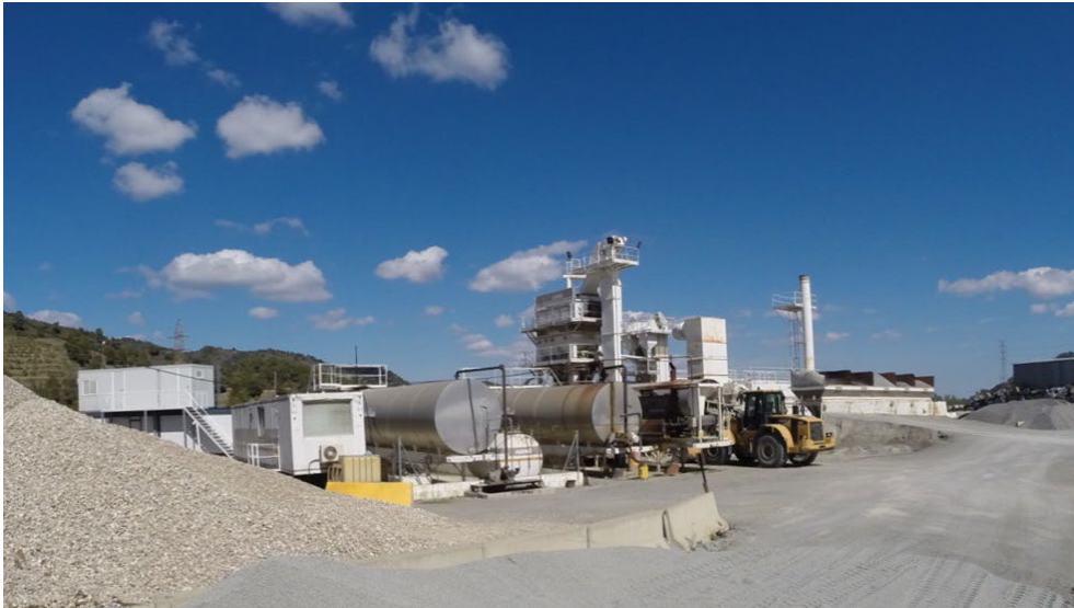
Fotografia 7: central de fabricació de la mescla SMA 11 PMB 45/80-65 amb fibres de cel·lulosa.
