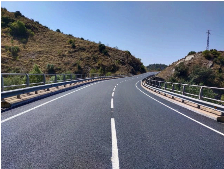
Fotografia 8: imatge de l'obra acabada.
