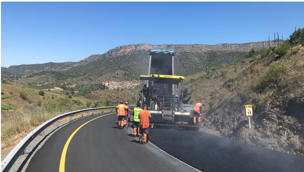
Fotografia 8: estesa de la capa de trànsit amb mescla SMA-11.
