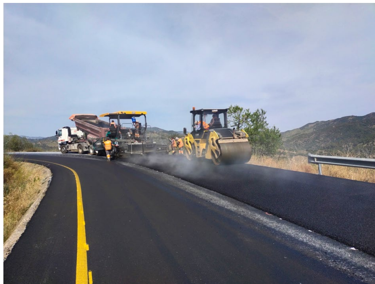
Fotografia 3: construcció del tram de prova.
