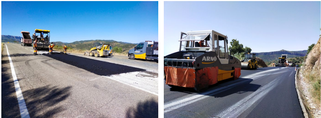
Fotografies 1 i 2: fressat i reposició en zones localitzades (esquerra) i posada en obra de la capa intermèdia (dreta).
