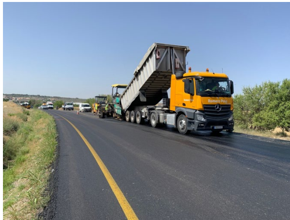
Fotografies 1 i 2: actuacions prèvies a l'estesa de la nova capa de trànsit. Rehabilitació estructural (esquerra) i estesa de la capa intermèdia (dreta).
