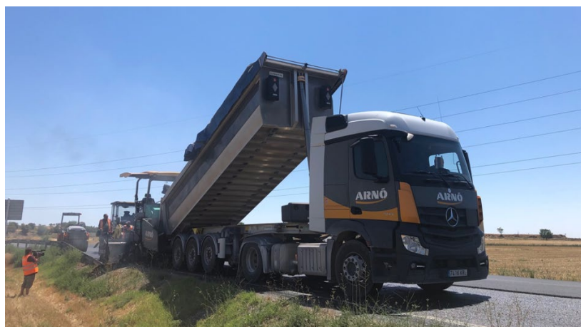
Fotografia 7: posada en obra de la mescla BBTM 11 B 50/70 NFU.
