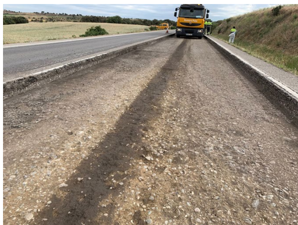
Fotografies 1 i 2: actuacions prèvies a l'estesa de la nova capa de trànsit. Rehabilitació estructural (esquerra) i estesa de la capa intermèdia (dreta).
