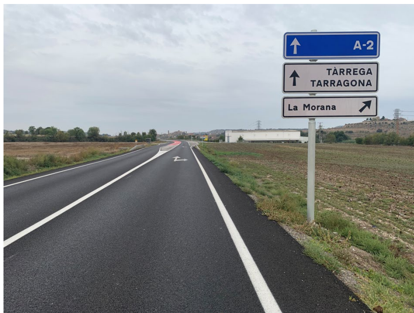
Fotografia 9: imatge de l'obra acabada.
