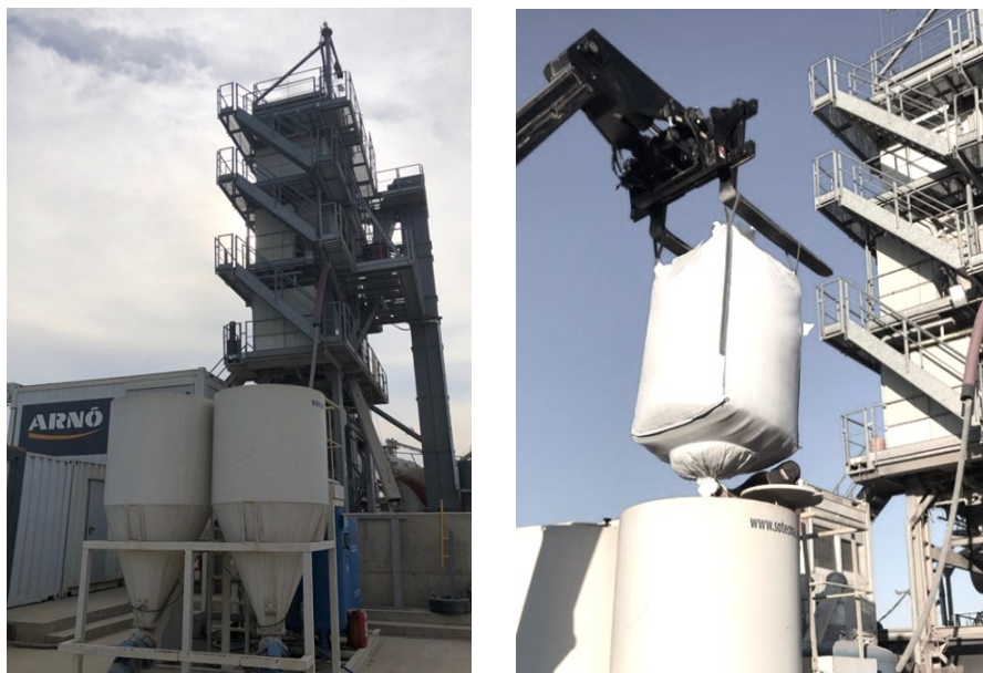
Fotografies 5 i 6: sitges per incorporar additius secs (esquerra) i descàrrega del cautxú (dreta).
