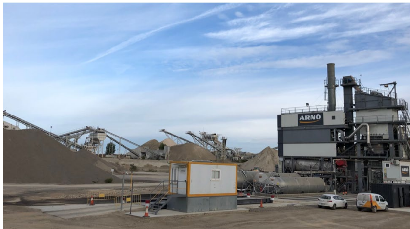
Fotografia 4: central de fabricació de la mescla BBTM 11 B 50/70 NFU.
