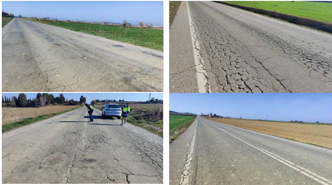
Imatge 1. Detall de l'estat previ de la via
