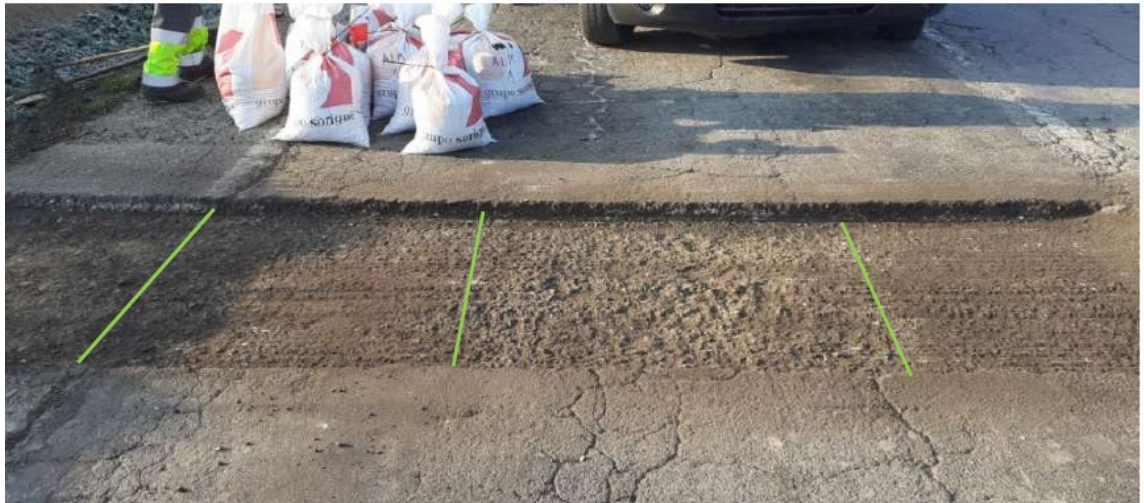
Imatge 6. Detall de l'execució de sondatges en el paviment
