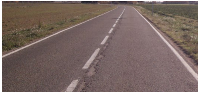
Imatge 2. Falla superficial de peladures longitudinalment a l'eix.
