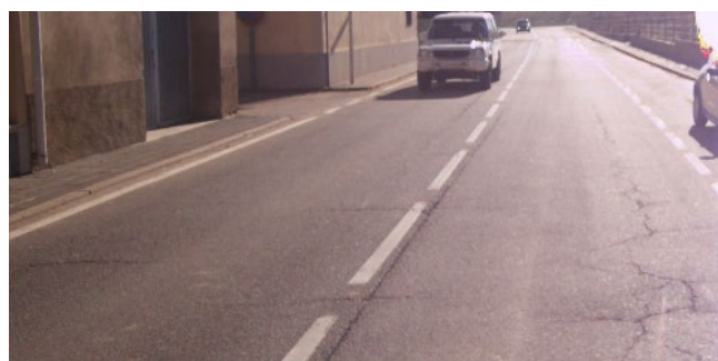
Imatge 3. Fissures longitudinals ramificades i transversals en població
