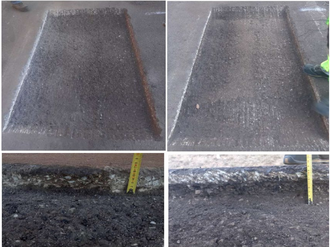
Imatge 5. Detall de dues dels sondatges executats
