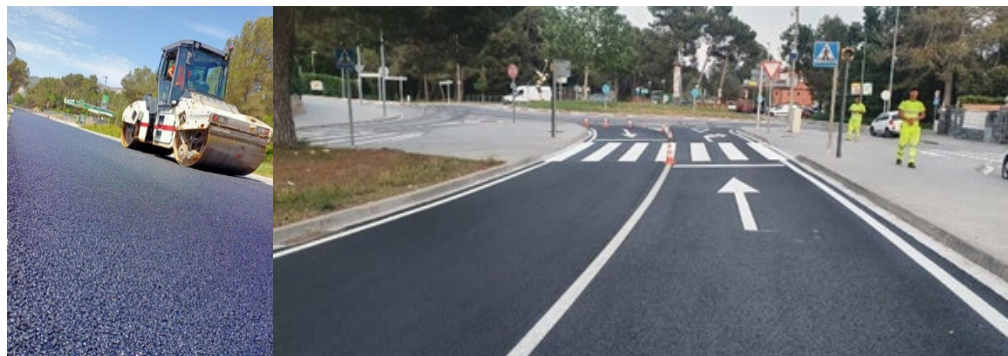
Figura 2. Detall de la compactació (esquerra) i tram finalitzat (dreta)
