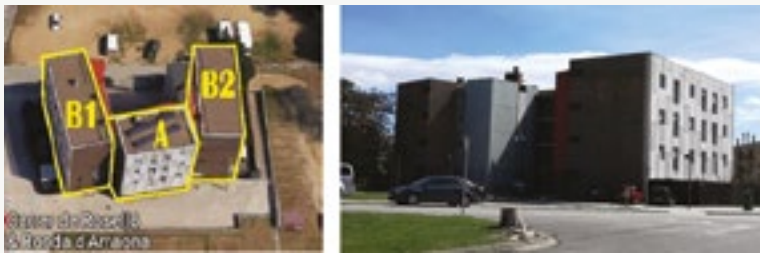
Bloc d'edificis abans d'implementar el sistema de façana Plug-n-Harvest (esquerra) i després (dreta). Font: AHC.
