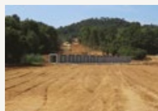
Variante d'Anglès carretera C-63. Obra de drenatge.
