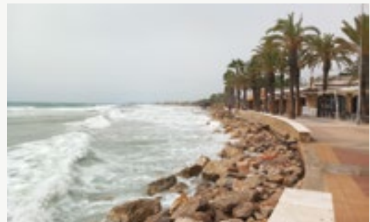
Efectes del retrocés de la línia de costa a la platja Llarga de Roda de Berà (dalt, 14 de novembre de 2018, baix, 4 de setembre de 2023).
