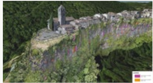
Vista del model en 3D de la cinglera de Castellfolit de la Roca. S'hi observen els desprendiments detectats els últims deu anys mitjançant el lidar terrestre (TLS, de terrestrial laser scanning). Font: ICGC.
