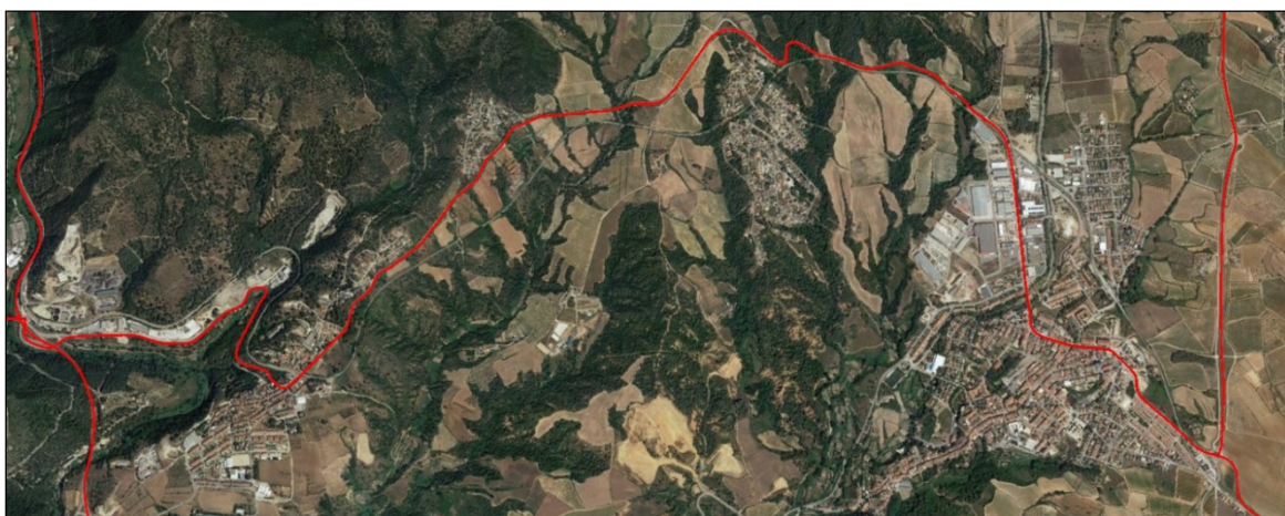
Trazado de la operación entre Capellades y Piera (provincia de Barcelona)
