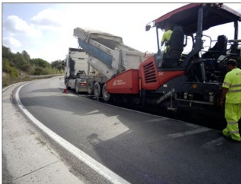
Trabajos de tendido
