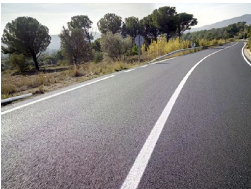
Mezcla tendida en uno de los tramos de la operación
