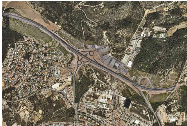
Figura 21. Fotografia aèria del nou enllaç.
