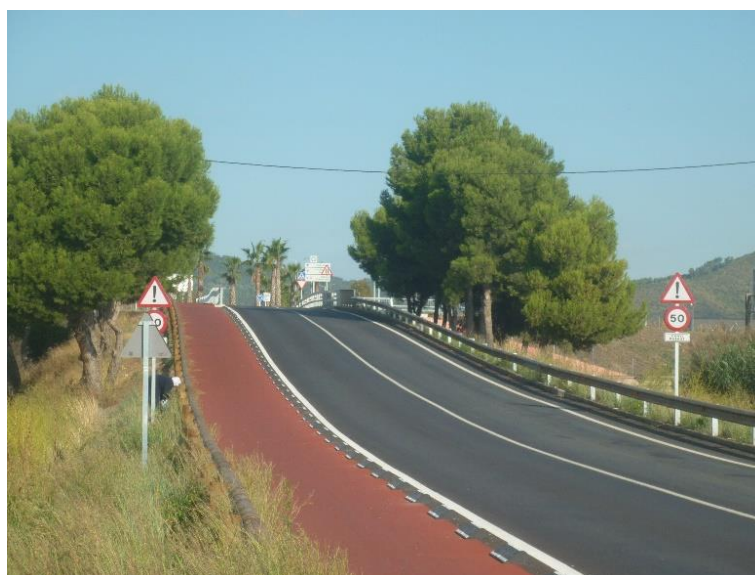
Figura 2. Renovació del paviment a la B-204.
