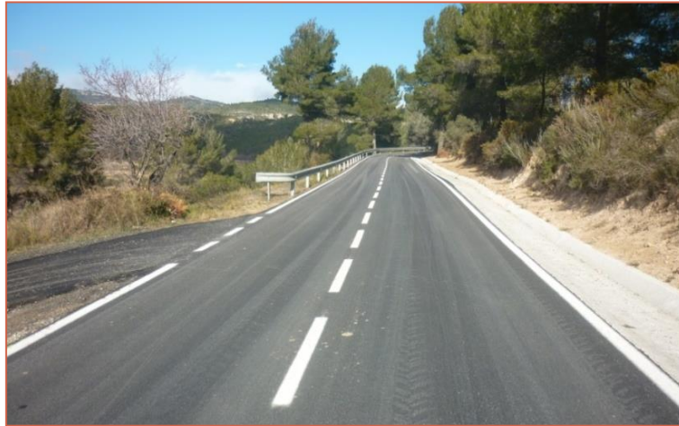
Figura 8. Renovació del paviment i formació de cunetes formigonades a la C-37.
