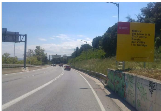
Figura 5. Àmbit d'actuació d'un dels trams analitzats.
