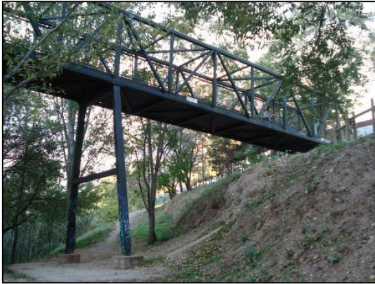
Fust múltiple amb riosta
