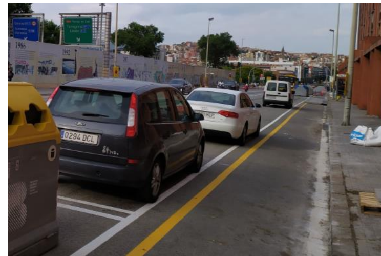
Obres de condicionament de carril bici lateral amb desplaçament del cordó d'aparcament. Pg. De Sta. Coloma, Barcelona
