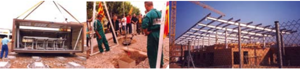
Desmuntatge dels mòduls
