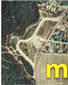
Obres d'urbanització iniciades
