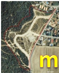
Obres d'urbanització iniciades
