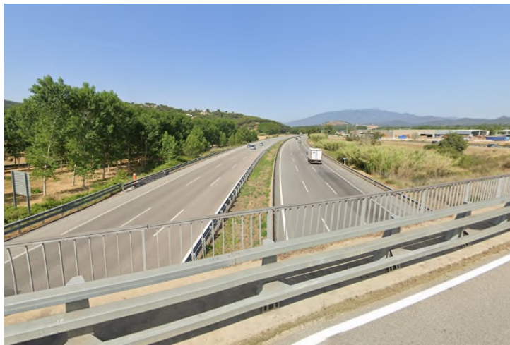
Il·lustració 13 - Autopista AP-7, tram Fogars de la Selva
