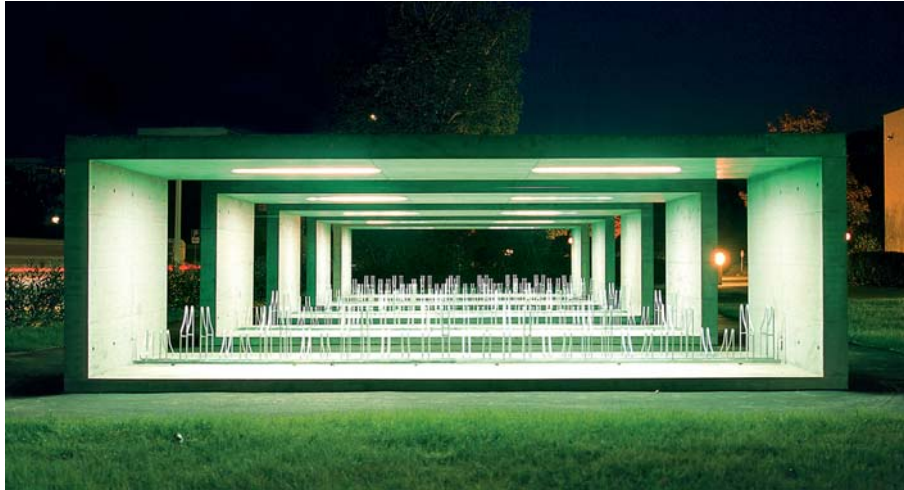
Imatge 2.42 Aparcament per a bicicletes il·luminat en un centre d'educació secundària a Zurich. Font: Architect & World
