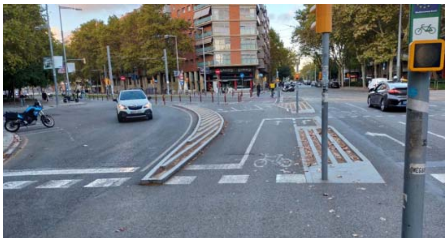
Imatge 2.31 Intersecció segregada i protegida per a bicicletes i patinets a Barcelona. Font: INTRA
