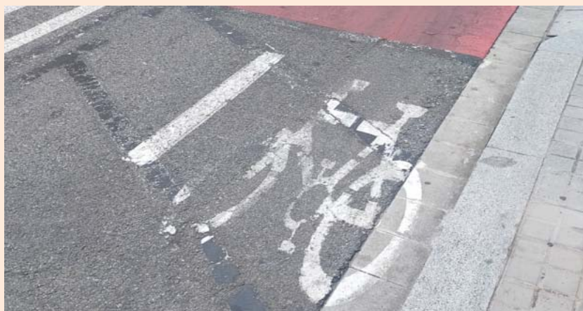
Imatge 2.16 Carril bici dibuixat sobre la rigola a Barcelona. La rigola no és un espai dissenyat per a la circulació. Font: INTRA
