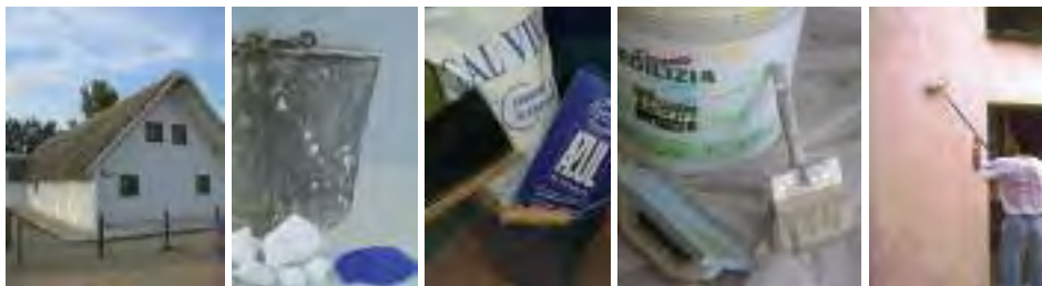
Aquesta construcció tradicional és emblanquinada periòdicament com a tasca de manteniment.
