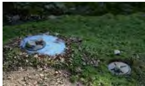
Les fosses de purins es poden soterrar completament, cosa que n'evita l'impacte visual i olfactiu.
