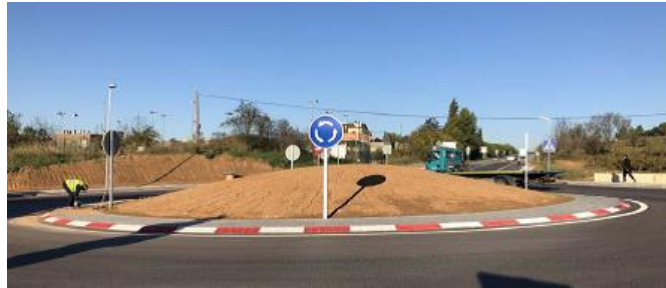
Figura 57. Imatge de la rotonda executada (Font: Memòria del Departament de TES 2018).
