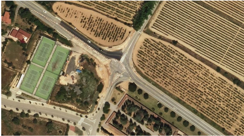
Figura 56. Localització del punt on es situarà la rotonda a la BV-2244 (Font: SIG Gencat).
