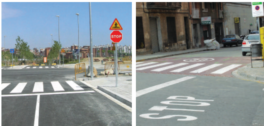
Cruïlles amb senyalització de stop, de forma vertical (esquerra) i horitzontal (dreta)
