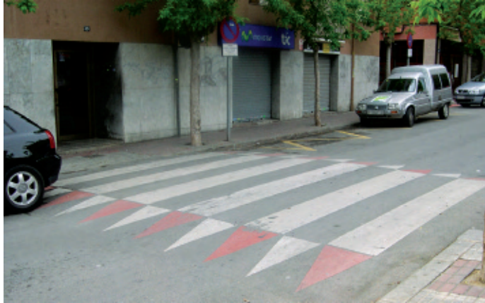
Figura 6.13. Exemple de pas de vianants de ressalt
