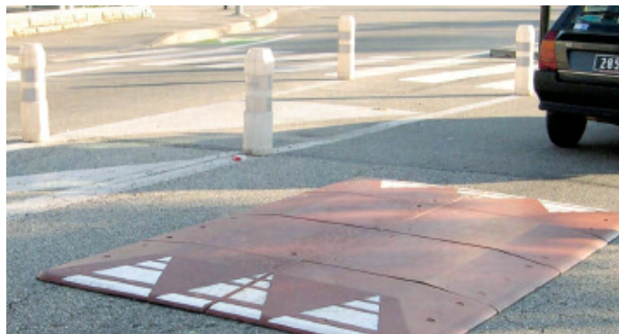
Figura 6.18. Exemple d'aplicació de coixí berlinès prefabricat
