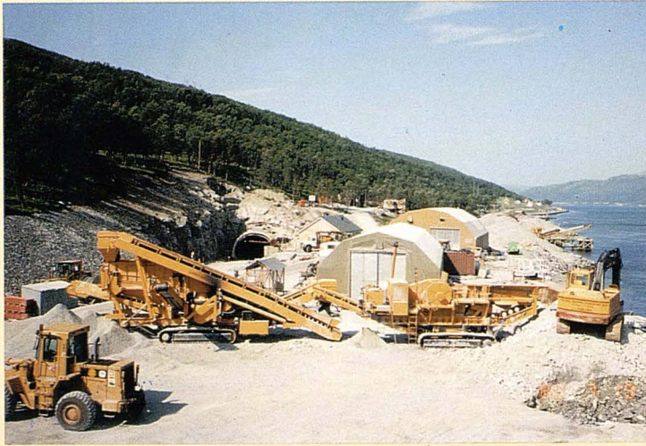
Túnel de KVALSUND en construcción.
