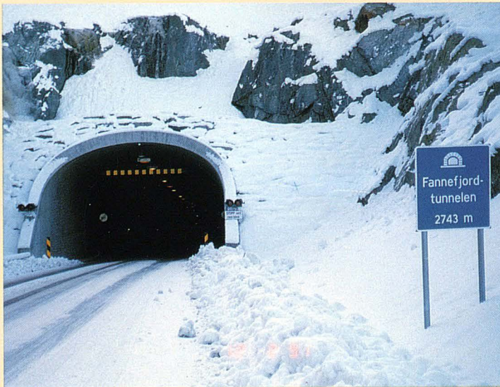
Túnel de FANNEFJORD. Portal del lado de BOLSØY.
