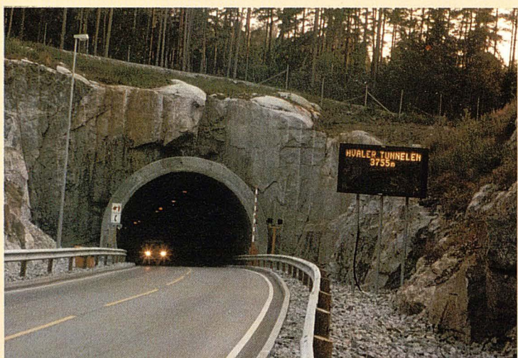
Túnel de HVALER. Portal sur.
