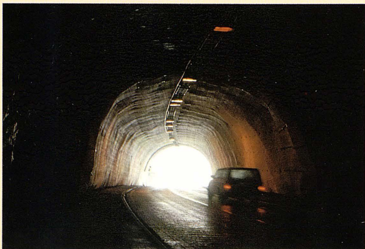
Interior del túnel de FLEKKERØY.
