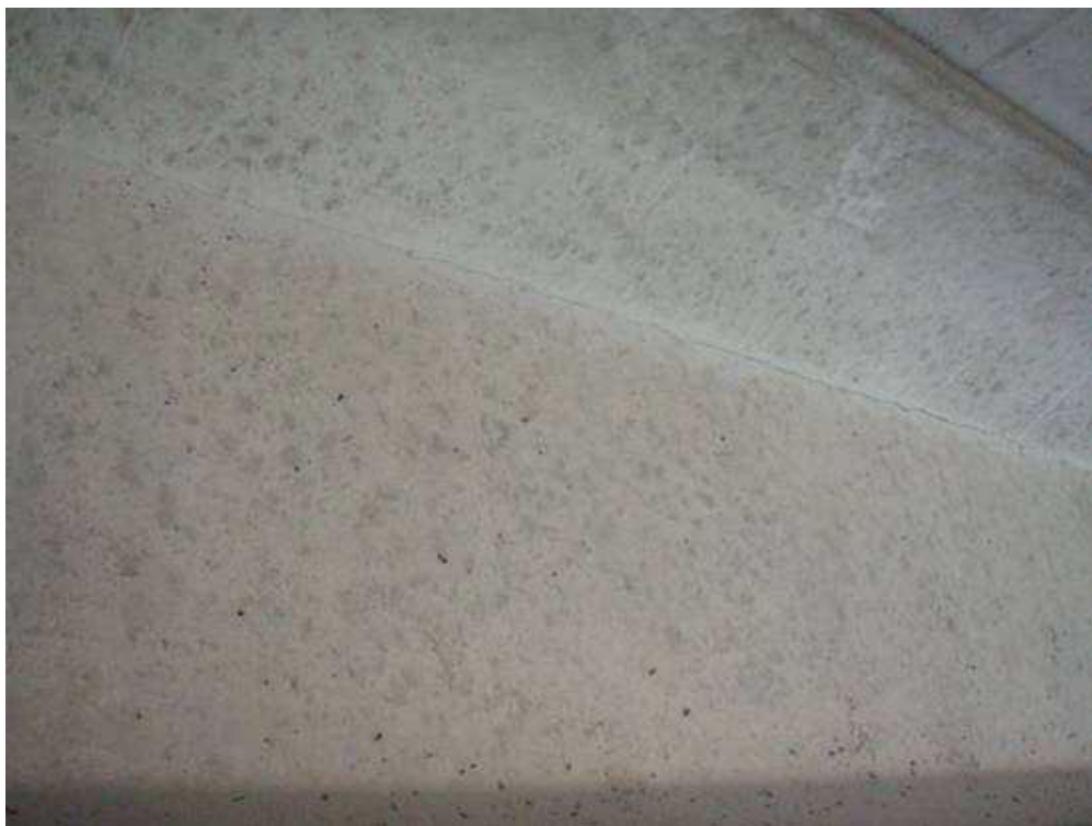
Fissures a la unió ala-ànima de les bigues, per falta de recobriment de l'armadura a l'aresta interior ala-ànima.
