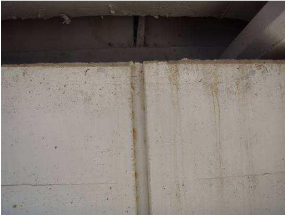
Fissures a la unió ala-ànima de les bigues, per falta de recobriment de l'armadura a l'aresta interior ala-ànima.
