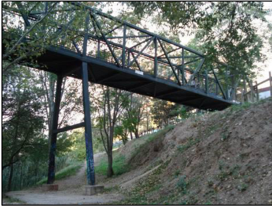
Fust múltiple amb riosta
