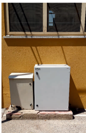
Cabines d'exterior per a propòsits de fibra òptica
