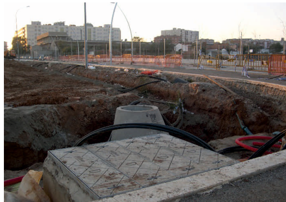
Construcció d'infraestructura soterrada
