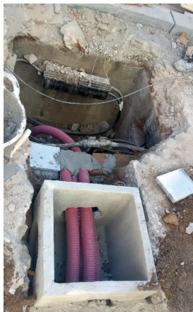
Pericó amb caixa d'empulaments
