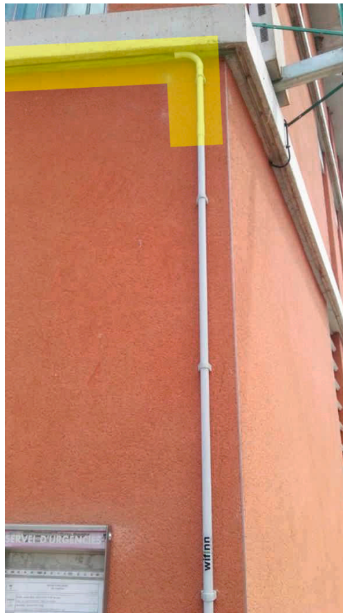
Canalització per façana i aprofitament d'elements d'obra preexistents (marcat en groc)
