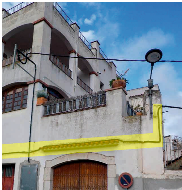
Tram per façana cap a tram aeri (marcat en groc)
