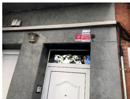
Tram canalitzat amb canaleta cap a tram sobre façana
