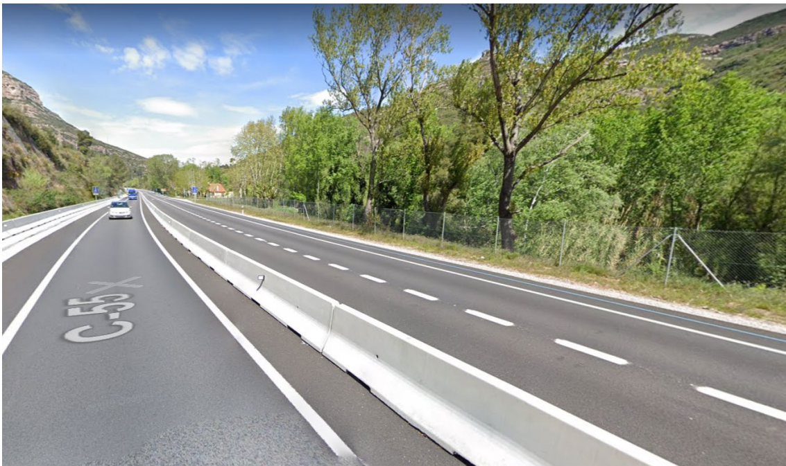
Figura 42. Estat actual de la carretera amb el tercer carril (Font: Google Street view).
