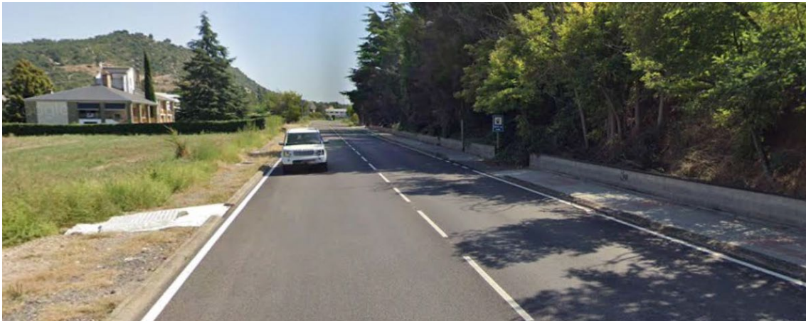
Figura 49. Imatge de després del reforç del ferm (Font: Memòria del Departament 2019).
