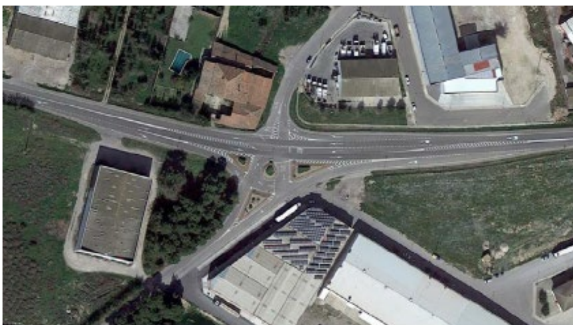
Figura 31. Cruïlla abans de l'actuació (Font: Projecte constructiu ML-16047).
