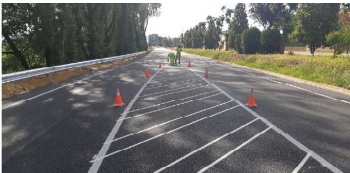
Figura 45 Nova zona zebrada (Font: Memòria obra executada MG-14709 OE).
